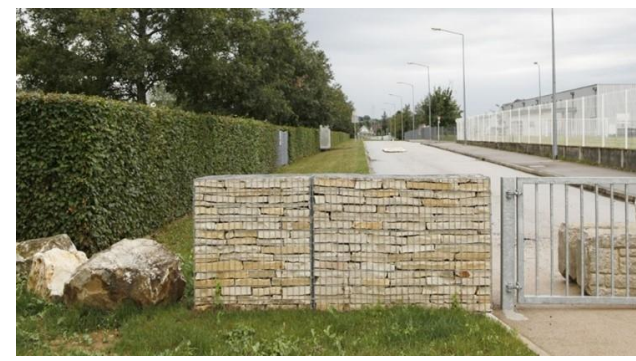
Exemple de gabion en pierres sèches accolé à un espace vert, ensemble favorable au Lézard des murailles
